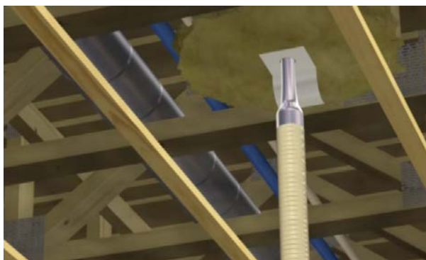
Innblåsing av løs isolasjon.....
